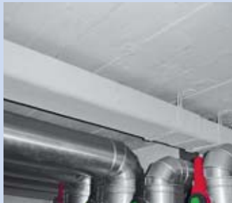
Canalina per cavi in fibrocemento
