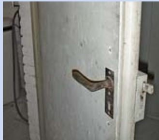
Porta antincendio con fibrocemento
