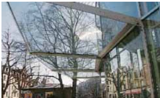
Tettoia con vetrata accessibile
